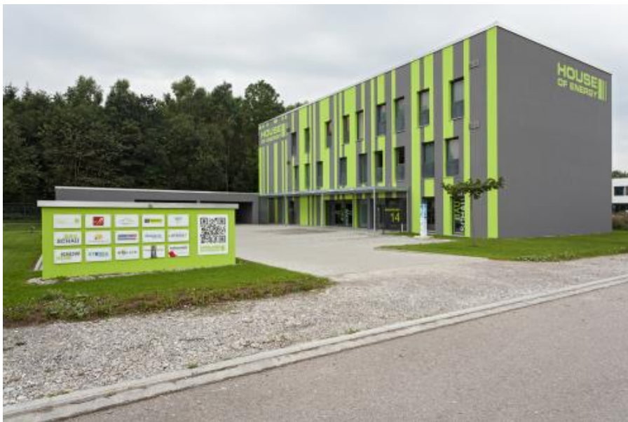
Das House of Energy in Kaufbeuren/Bayern ist eines der nachhaltigsten Bürogebäude der Welt. Bildquelle: Henrik Schipper Fotografie
