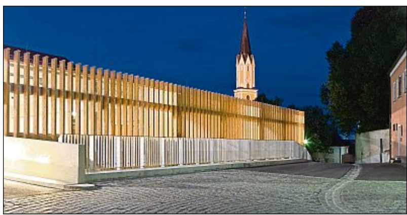
Das neue Parkhaus wurde an einem sensiblen Punkt in der Altstadt errichtet.
