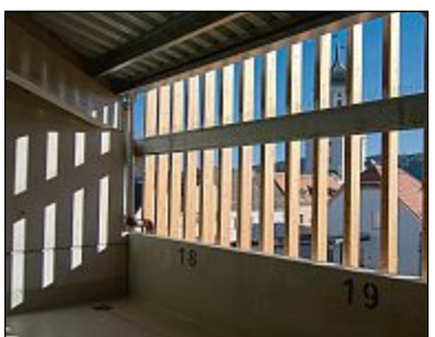
Licht- und luftdurchlässig: Das Parkhaus ist kein düsterer Unort.
