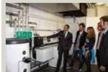
Ein Euro Heizkosten pro Quadratmeter und Jahr: Das „House of Energy“ ist ein Sparmodell, das mit einem Minimum an Heiztechnik auskommt, wie Hausherr Markus Meyer den Besuchern zeigt.
