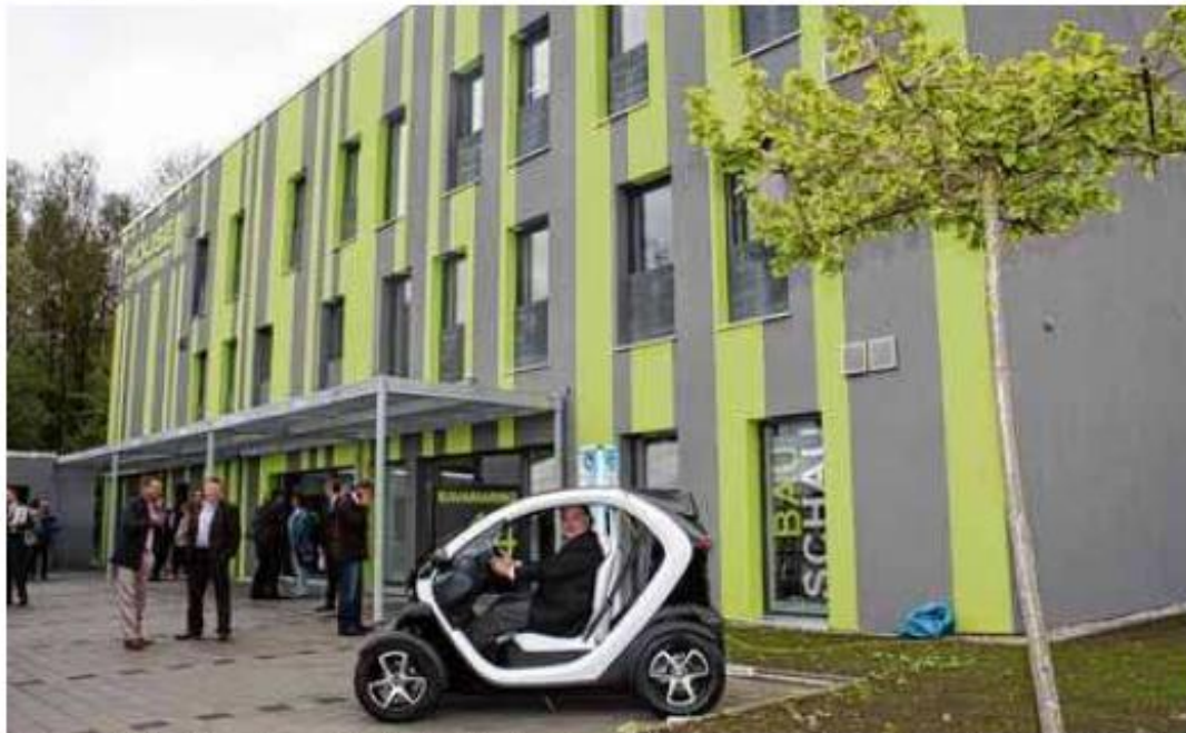
Der Firmensitz des Unternehmens „Airoptima“ und anderer verwandter Betriebe am Kaufbeurer Bavariaring hat viele Besonderheiten – neben einem Strichcode als Fassadengestaltung auch eine öffentliche Elektrotankstelle im Eingangsbereich. Fotos: Vucko
