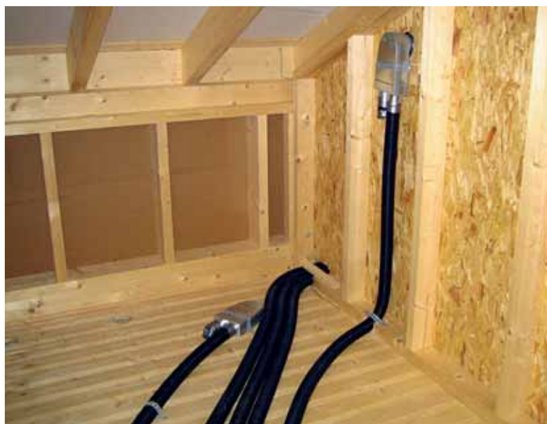
Durchdachte Planung: Die Lüftungsleitungen wurden mit großen Biegeradien verlegt. Die Umlenkstücke für Wandventil und Deckenauslass sind sauber in den Holzbau integriert
